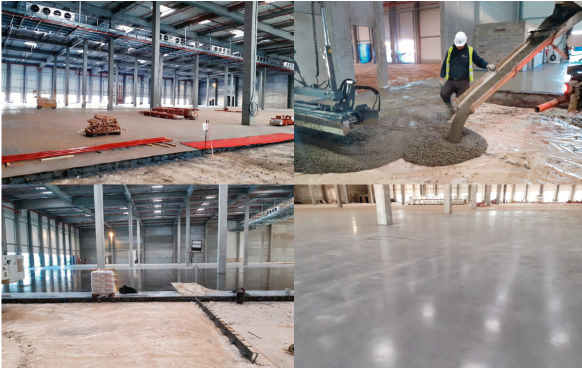
← Coulage de la dalle industrielle.
